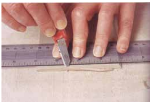
FIGURA 97 – FAZENDO CHANFROS DE 45° NAS BORDAS
